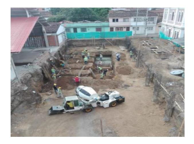
Se empieza con la Excavación del semisótano conforme a los planos del plan maestro.
